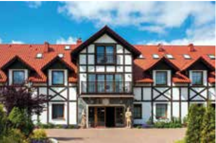
Restauracja Nordowi Mól, Celbowo, zintegrowany system instalacji OZE (pompa ciepła, instalacja PV i solarna).
